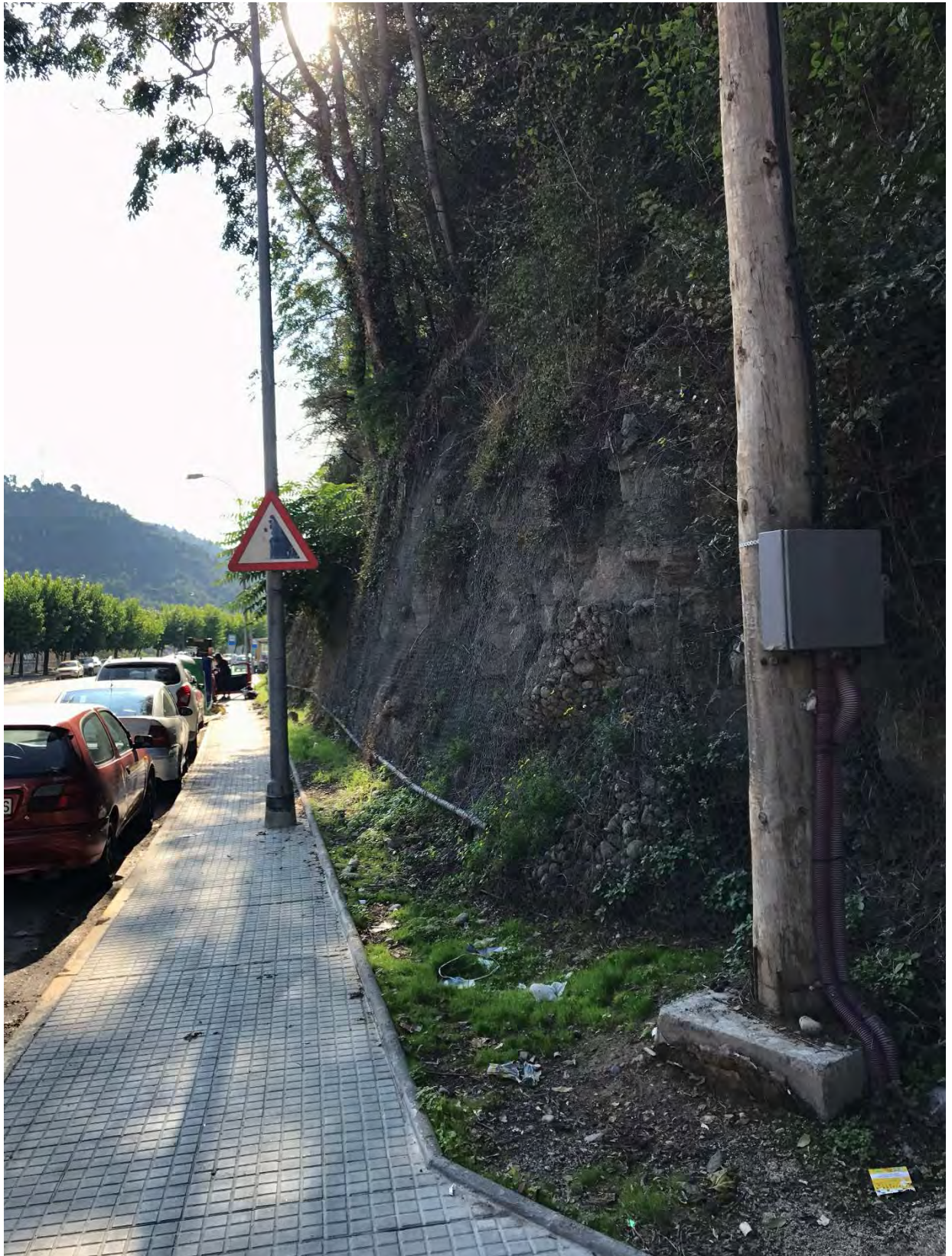
Aspecte actual de la vorera del Carrer Estació on es preveu eixamplar i construir un mur d'acer corten.
