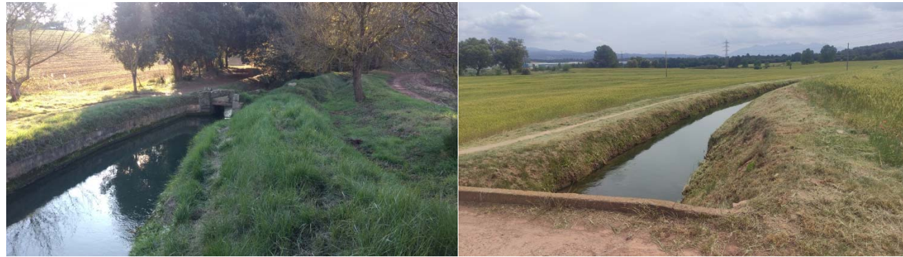
Detalls de la Séquia de Manresa. Font: DRC.
