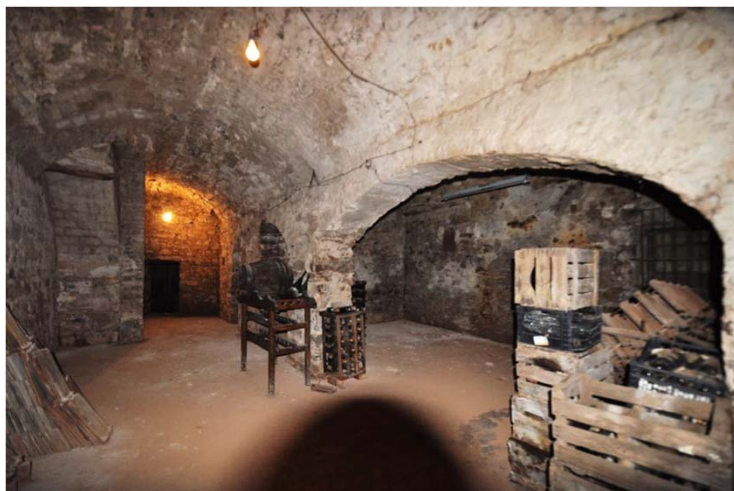
Cellers en soterrani de gairebé tots els immobles del nucli antic (073EA. Carrer de la carretera, 3)
