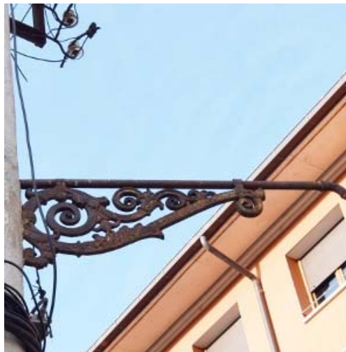
02BSE. Enllumenat de gas del s.XIX
