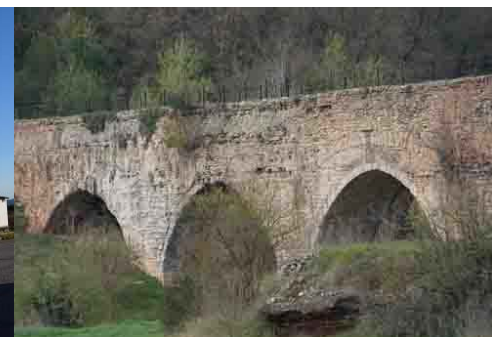
09CA Ponts i aqüeductes
