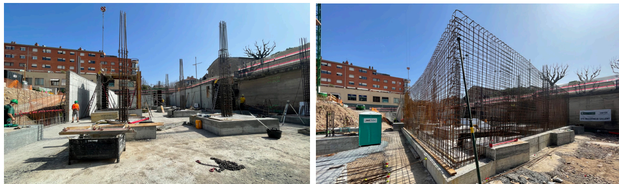
Estat de l'estructura de la futura residència i centre de dia. Imatges del 19/03/2024.
