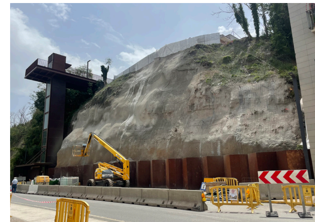
El nou talús del carrer Estació durant les obres d'estabilització.
