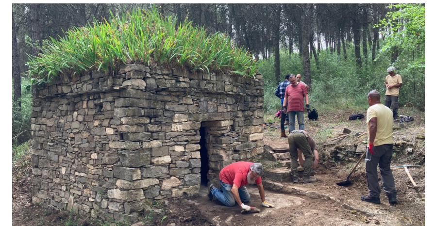
Treballs de recuperació en una barraca de pedra seca.
