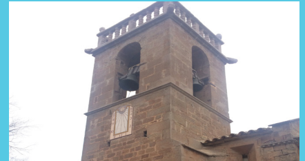
Reparació de torre, façanes, àbsis i finestres, balaustrada i coberta del campanar de l'Església de Cornet
