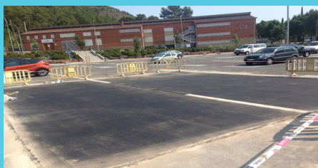
Reparació de l'aparcament de la Plaça Santa Maria
