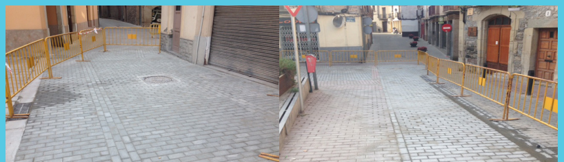
Pavimentació de la llamborda dels c/Torres Amat i Bisbe Valls
