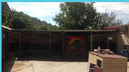
Reparacions de la protectora d'animals: teulada i canal de reg
