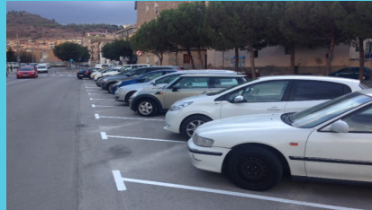
Pintura aparcament Pont Nou i Camp de la Bota
