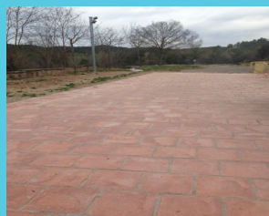
Pavimentació del pati de Cornet
