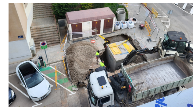
Imatge de les obres al carrer Camp de la Bota.
