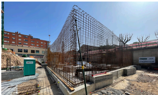
Estat de l'estructura de la futura residència i centre de dia. Imatges del 19/03/2024.
