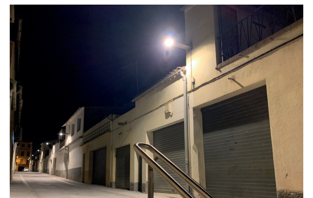
Aspecte del nou Passatge de les Vinyes.
