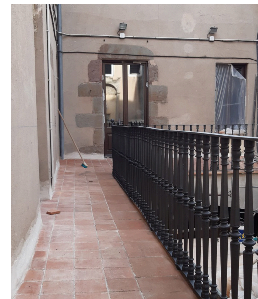
Aspecte del nou paviment del terrat i de la barana del pati de la Casa Torres Amat.
