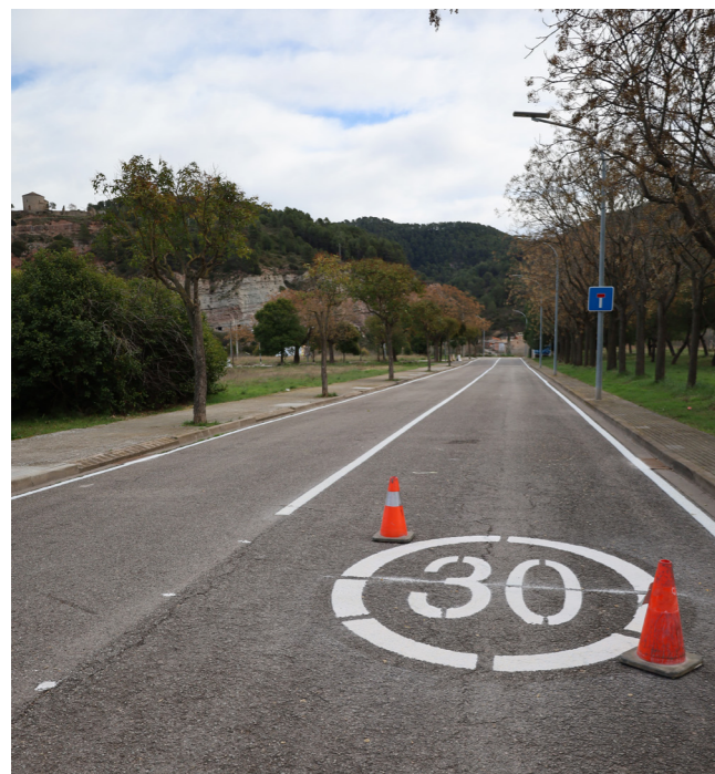
Imatge de la preparació de la calçada per al trànsit.
