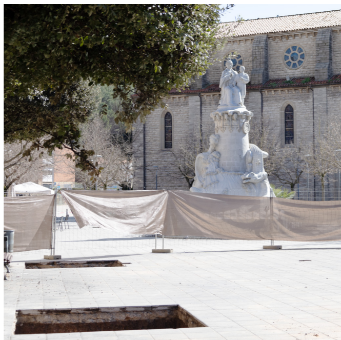
La plaça amb les perforacions per instal·lar els suports enllestides.
