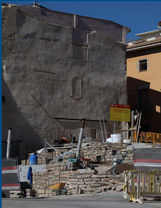
Les diferents feixes de pedra del carrer Molí al tram final de l'obra.
